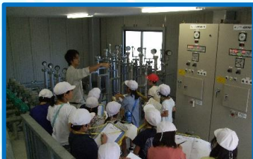
北橋頭首工施設内部見学
