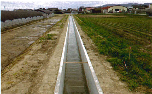
県営水利施設整備事業「上堰下流地区」 平成29年度施工（桑田堰 狩川地内）
