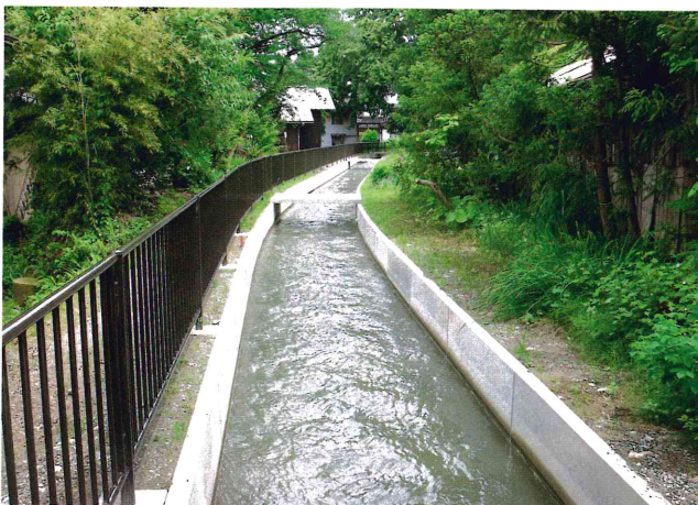
県営水利施設整備事業「上堰八カ村堰地区」
