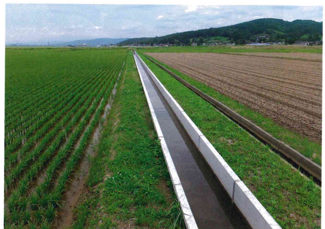
県営水利施設整備事業「上堰下流地区」
