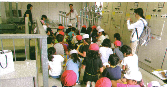
北楯頭首工の説明(頭首工管理施設内)
